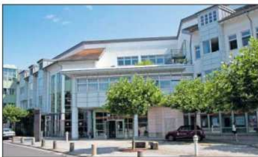
In der Hauptgeschäftsstelle in Rockenhausen wird derzeit umgebaut: Dort wird im Mai ein Kunden-Service-Center angesiedelt, wo telefonische Anfragen und welche über das Internet bearbeitet werden. ARCHIVFOTO: J. HOFFMANN
